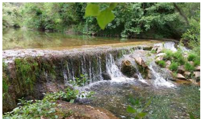
Ouvrage type « barrage », Orbieu
