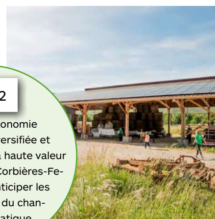
Soulatgé, autoconsommation collective, hangar agricole « Les Embialades » ©Waga photos
