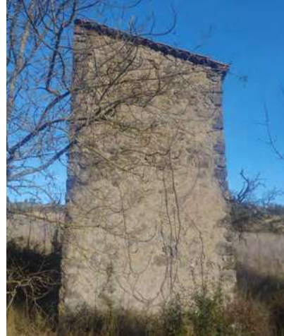
Bâtiment communal qui pourrait être restauré (ancien poste électrique), Laroque-de-Fa
