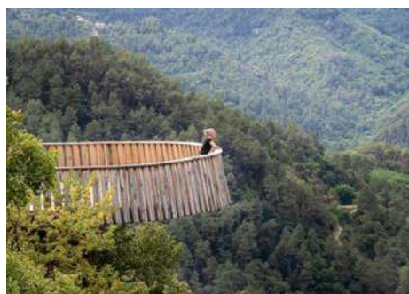
Valorisation et amélioration d'un belvédère existant
