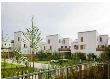
Construction de logements collectifs en périphérie, parc pour espace tampon avec zone naturelle
