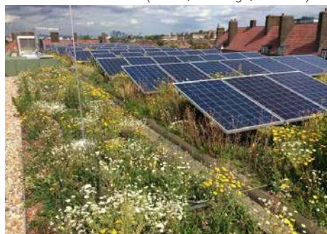
Panneau photovoltaïque en toiture sur bâtiment industriel
