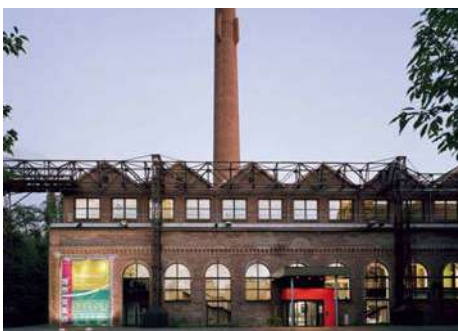
Réhabilitation d'ancien bâtiment industriel
