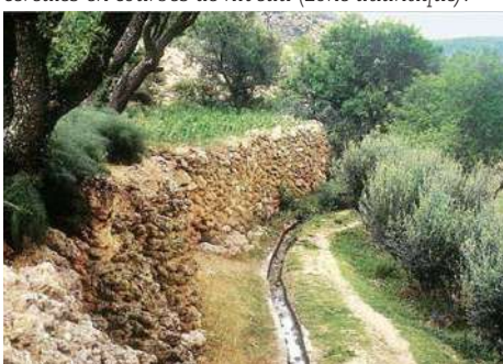
Terrasses, murets en pierres et séguia (béal) drainant le pied du talus. Polyculture sous les oliviers (Rif occidental).
