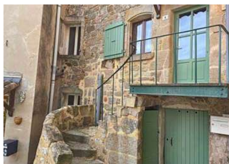
Rénovation du bâti existant pour favoriser le logement à l'année
