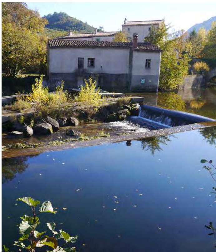
Barrage sur l'Aude à Quillan ©Atelier Refuge
