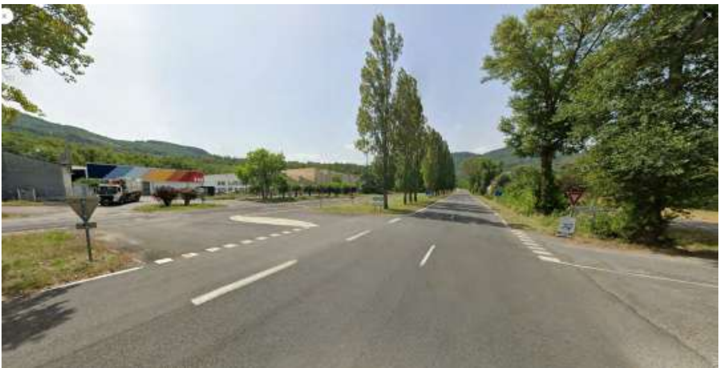
Dédoulement de la RD 118, et caractère routier des aménagements à l'entrée nord de Quillan ©Google Streeview
