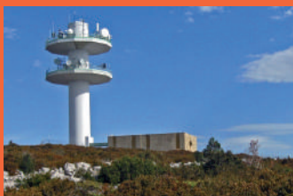
Tour de télécommunication à proximité de la Tour des Géographes
